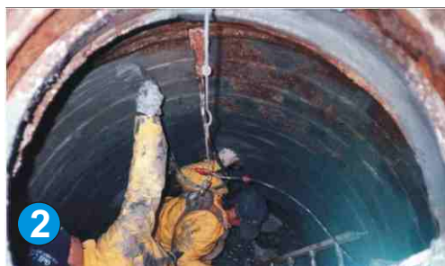
2. Dopo aver otturato le perdite con ENECRETE WP, le pareti sono pennellate con due mani di WS...
